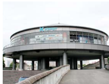
新横浜公園内、日産スタジアムのすぐ隣に位置する新施設
